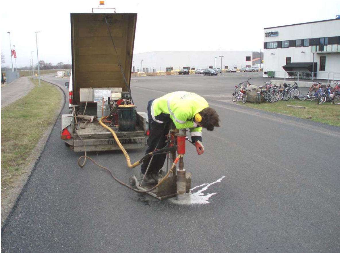
Bild 2-2 Uppborrning av provbeläggning med AG och slitlager av ABS i april 2011.
